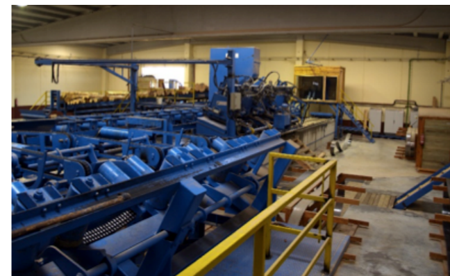
Figura 25: Instalaciones del ACMSA en Mohorte (Cuenca). Fotografías propias de UFIL.
